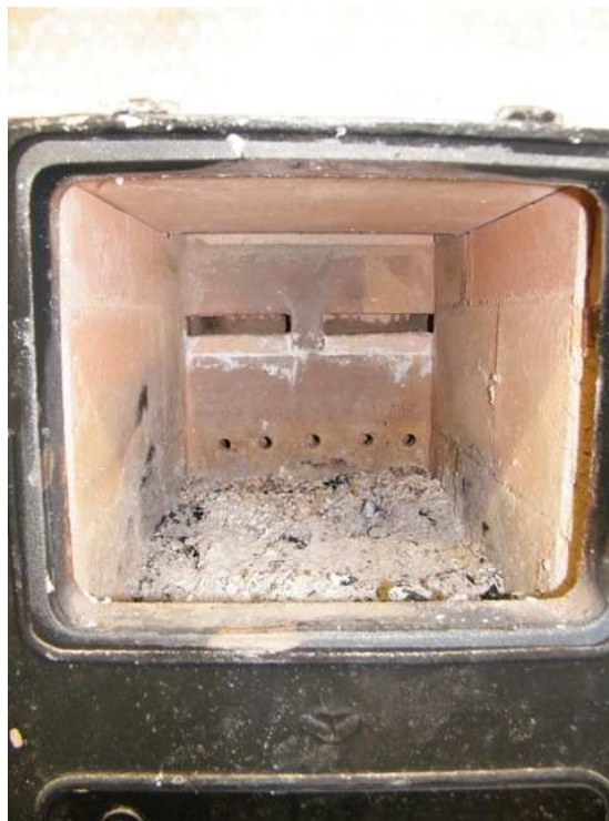
Joonis 8. Täiustatud ja isoleeritud kolle õhuavadega tagaseinas.
