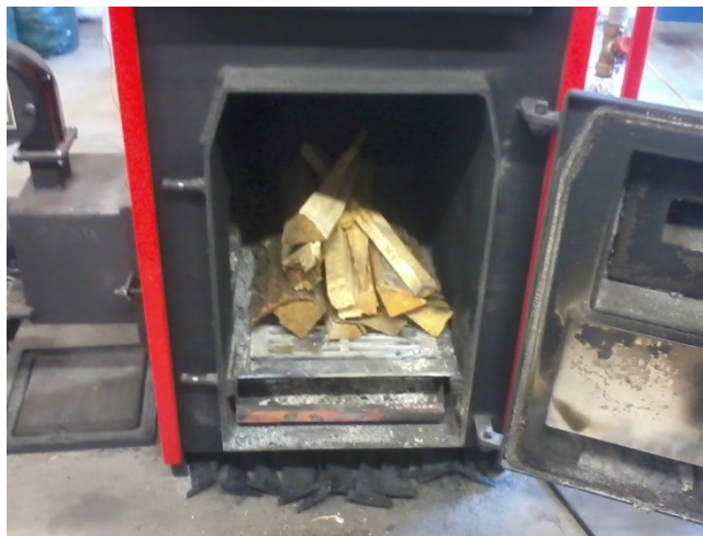
Joonis 1.1. Puude paigutamine ahju
