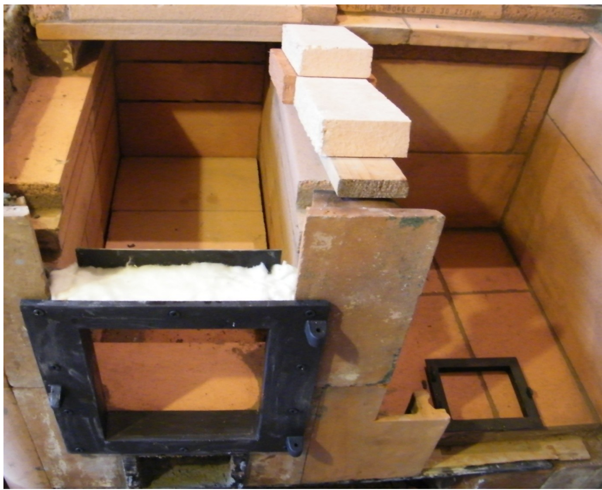
Joonis 2. Pliidi pilukolle, milles saab puhtalt põletada kuni 3,7 kg puitu (Foto Lauri Lõhmus)
